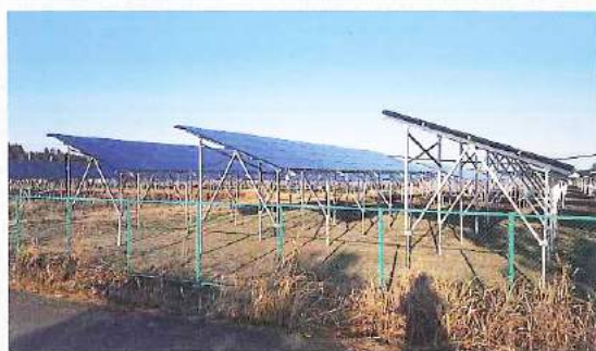
架台の高さは2.2m。下でミヨウガを育てる
